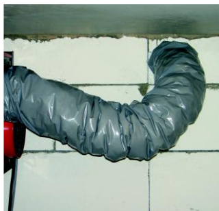
Prawidłowy montaż, lekkie zgięcie.
