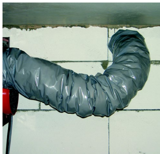
Korrekt montering, svag böj.
